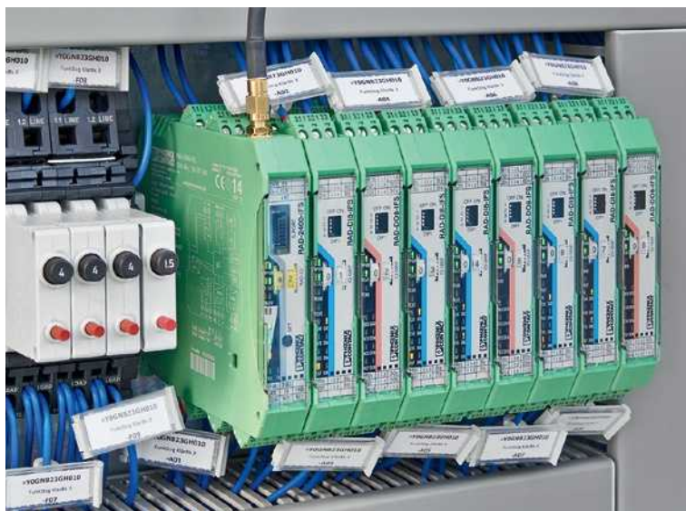
Radioline 系统的主模块能够以模块的方式进行扩展，最多可增加至32个 I/O 模块。
