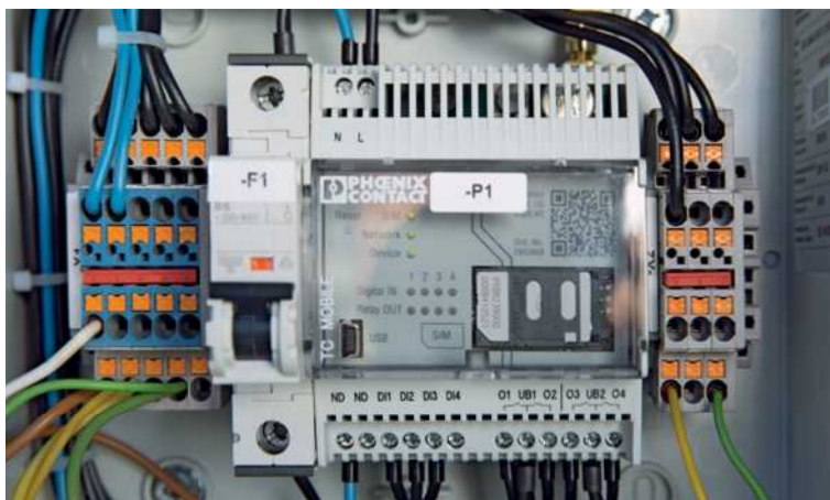
外型小巧，但通讯能力强：紧凑型TC Mobile X300遥控装置
