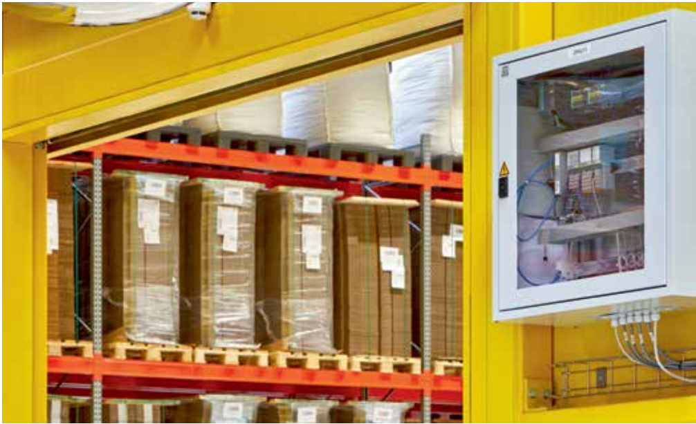
AXC Cloud-Pro控制器和并排安装的I/O模块从分布在多个储藏室的温度传感器获取数据
